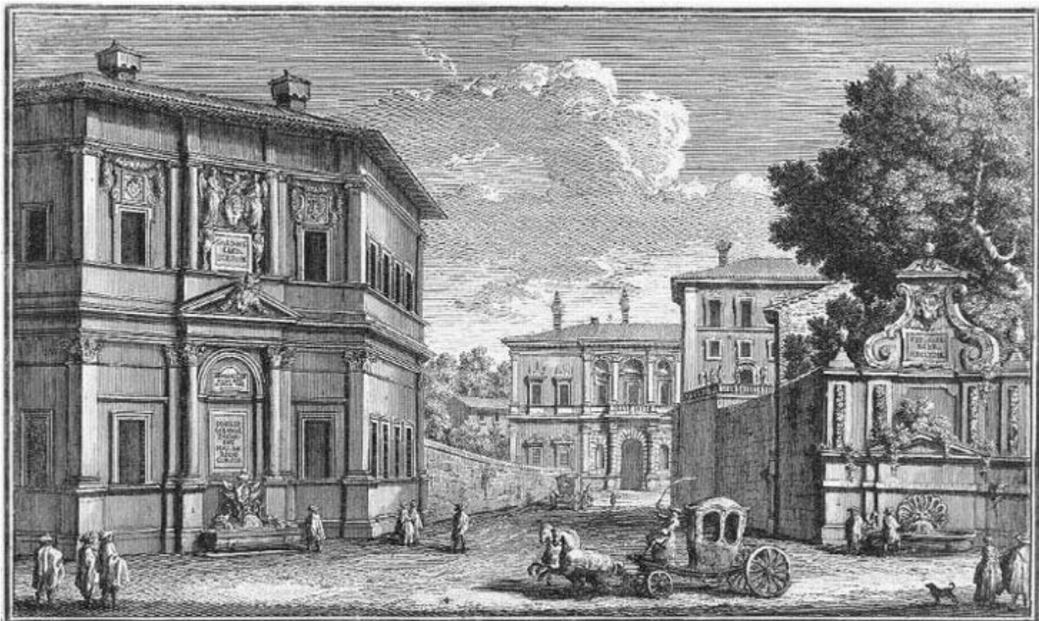
Casino della Piazza di Papa Giulio III. 1. Prospetto del Casino, e fontana sulla Via Flaminia, 2. Casino, e fontana della Villa Soubaldy, 3. Casino della R. C. A. architettura di Giacomo Barozzi da Vignola.
